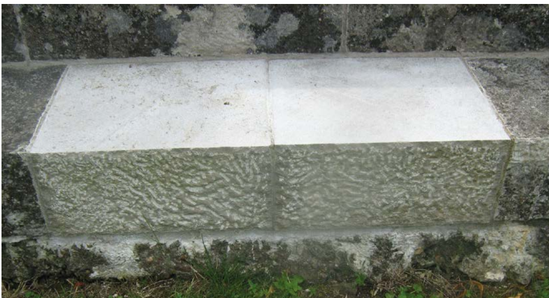
Pan fydd yn hanfodol gosod cerrig newydd yn lle hen rai, dylid naddu'r garreg newydd i gyfateb i'r garreg wreiddiol. Yn yr enghraifft hon o Sain Ffagan, mae'r arwyneb uchaf yn llyfn ac mae ymyl yr arwyneb wedi'i erwino er mwyn cyfateb i'r garreg wrth ymyl (© yr Ymddiriedolaeth Cofebion Rhyfel).
