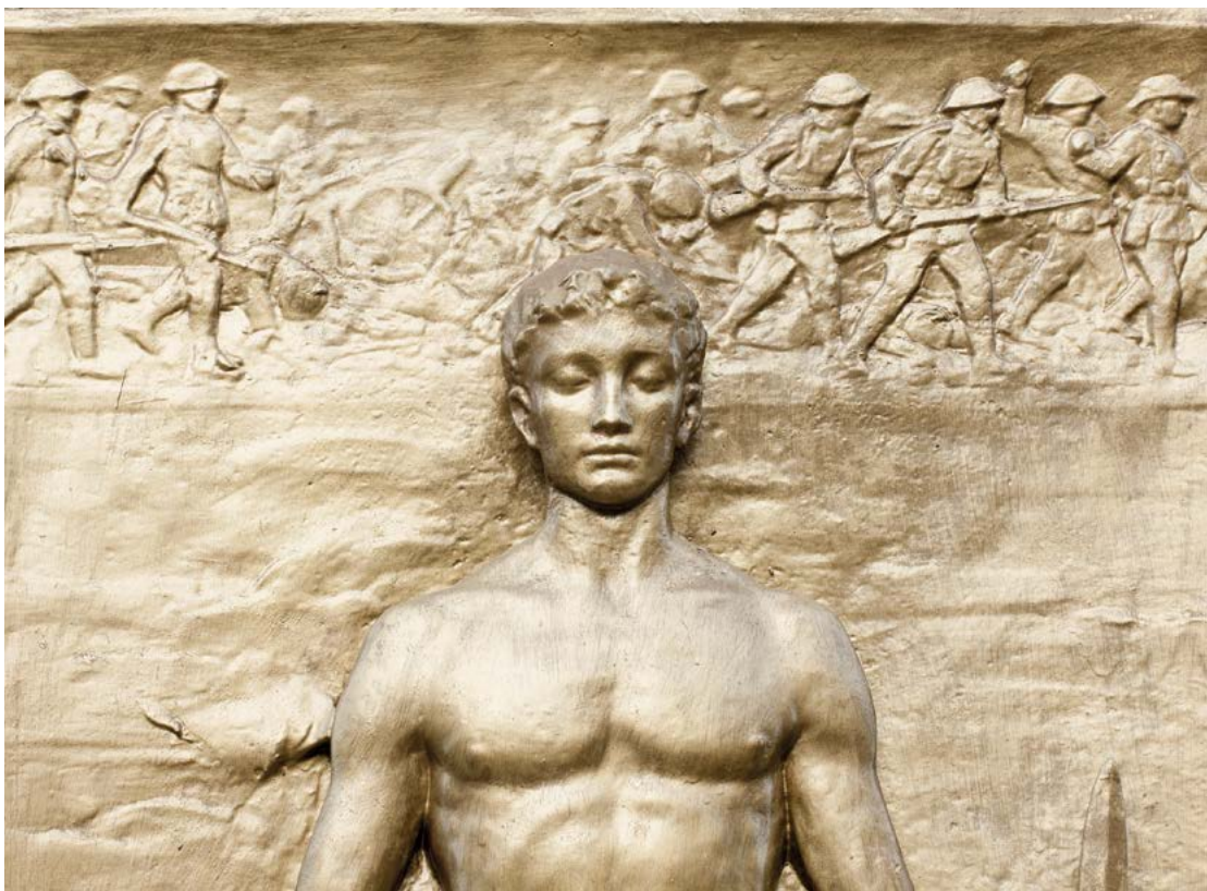
Mae'r olion brws ar y gofeb hon yn awgrymu bod paent efydd wedi'i ddefnyddio naill ai i geisio adfer yr efydd neu i'w atal rhag dirywio. Mae'n debyg bod hyn wedi newid golwg y gofeb ac nid argymhellir y driniaeth hon ar gyfer efydd.
